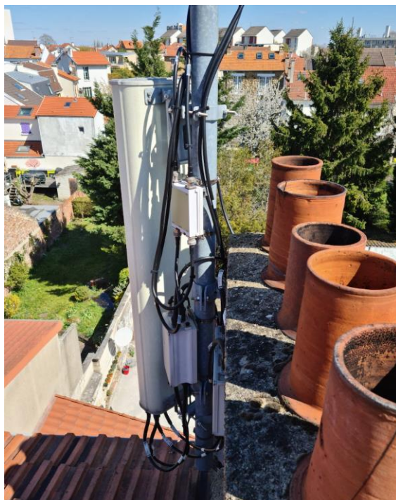
Vue de la terrasse S0 avant travaux
